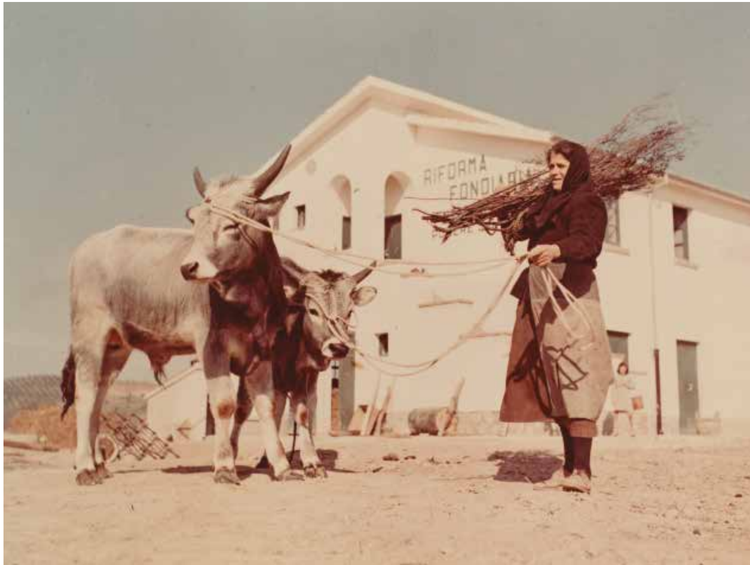
(Fig.27) La riforma agraria degli anni '50 del secolo scorso prevedeva la realizzazione di nuove abitazioni per i coloni The agrarian reform in the 1950s included building new homes for the farmers
