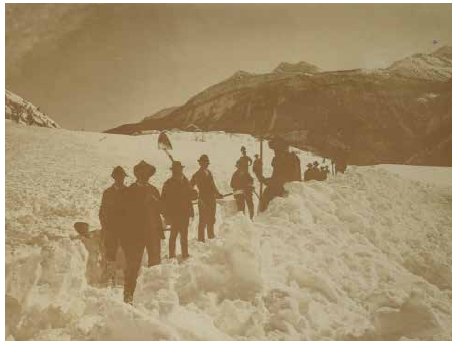
(Fig.43) Valanghe. Courmayeur, 1904. Escavazione d'una strada sul dep. [deposito] d'espansione d'una valanga polverosa discesa dal M.te Cornet" (Firenze, Museo della Fondazione Scienza e Tecnica, n. 437 (434) Cat. XV "Fotografie, parte 1") Avalanches. Courmayeur, 1904. Excavation of a road on the dep. [deposit] of expansion of a powdery avalanche descending from Mt. Cornet (Florence, Fondazione Scienza e Tecnica Museum, no. 437 (434) Cat. XV "Fotografie, parte 1")
