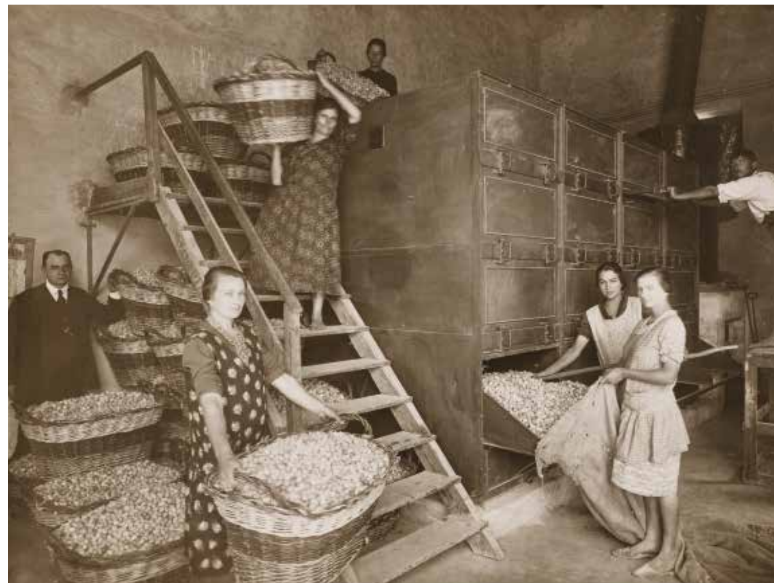
Essiccatoio per i bozzoli del baco da seta, anni '20 del XX secolo Cocoon dryer (1920s)
