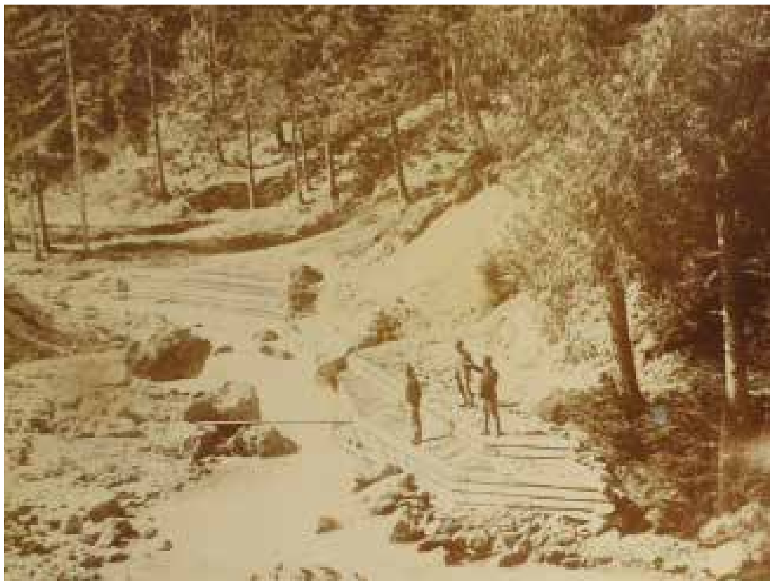
(Fig.42) Erosione e sedimentazione fluviale. La difesa dell'argine nelle curve (Firenze, Museo della Fondazione Scienza e Tecnica, n. 129 Cat. XV "Fotografie, parte 1") Erosion and fluvial sedimentation. Embankment defence in the curves (Florence, Fondazione Scienza e Tecnica Museum, no. 129 Cat. XV "Fotografie, parte 1")
